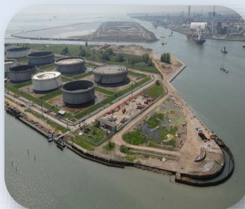
Isola dei petroli, aerial view
